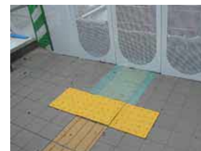
工事中には、貼付式の点状（警告）ブロックを暫定的に敷設
