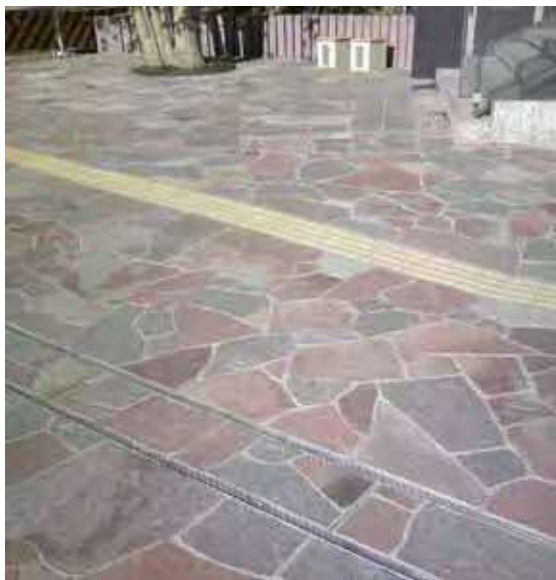
アルゼンチン斑岩のミックスレッドによる舗装 (厚さ50mm) (赤70%、グレー20%、バイオレット10%)
