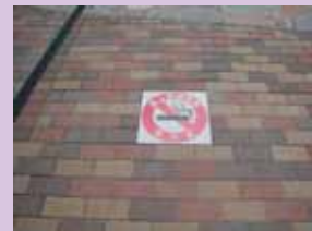
歩道内に設置したブロックで表示
