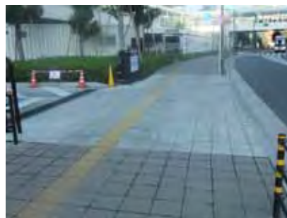
歩道切下げ部においても連続した誘導ブロックを設置
