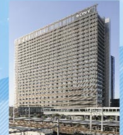
ソニーシティ大崎(現NBF大崎ビル)(西口C地区)敷地面積約1.7ha 2011年竣工
