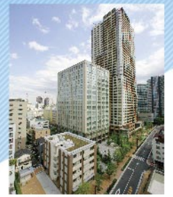
東京サザンガーデン(東五反田二丁目第2地区)地区面積約1.8ha 2010年竣工
