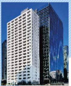
大崎ウィズシティ(大崎駅西口南地区)地区面積約1.1ha 2014年竣工
