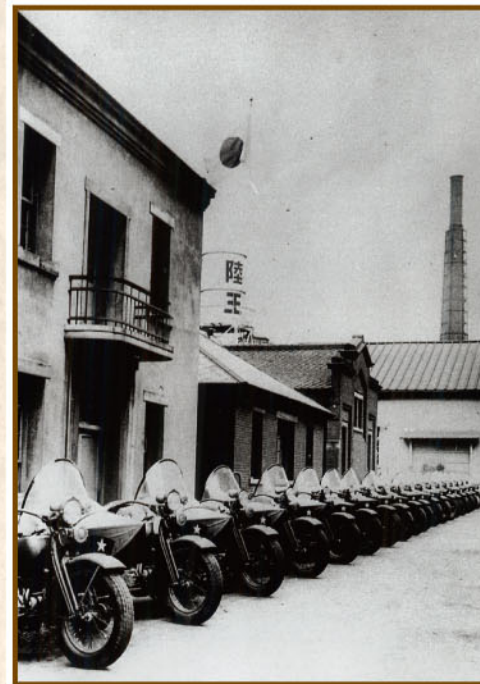
戦時中の昭和10年代末期、陸王内燃機・品川工場に並ぶ陸王。昭和25年には昭和飛行機(株)と三共(株)の共同出資により「陸王モーターサイクル(株)」として再スタートするも、時代のニーズに呼応できず昭和35年に製造中止へ。
