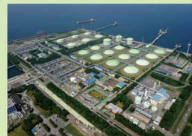
耐震性の高い設備 都市ガス製造工場
